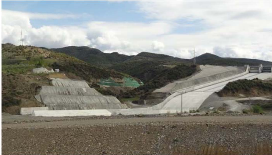
Figura 9: Diga e Banjës – Tregon shkarkuesin nga përmbytjet dhe bankinat mbrojtëse në bjeftin e poshtëm
